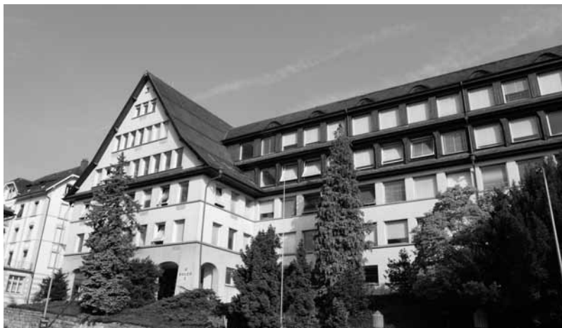
Hlavní sídlo společnosti Sputnik Engineering AG v bývalé budově Rolex v hodinářské metropoli Biel ve Švýcarsku.
